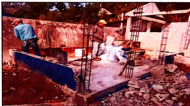
Foto 16: Reparación de pared de cocina.
