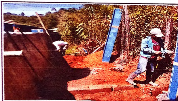
foto 3: susticion de base para tinaco
