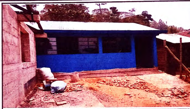
Foto 8: Sustitucion de canales pluviales
