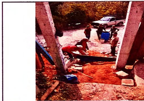
Foto 10: Reparacion de portones
