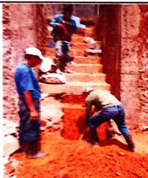
Foto 15 reparación de muro de contención
