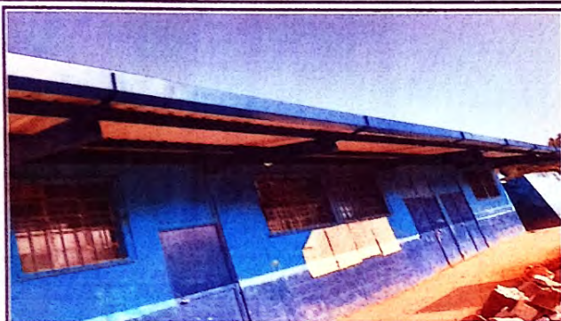
Foto 7: Sustitucion de canales pluviales
