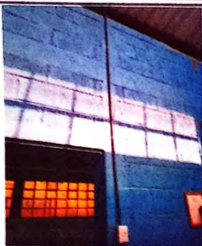
Foto 13: Reparación de sistema eléctrico
