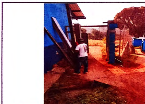
Foto 9: Reparacion de portones
