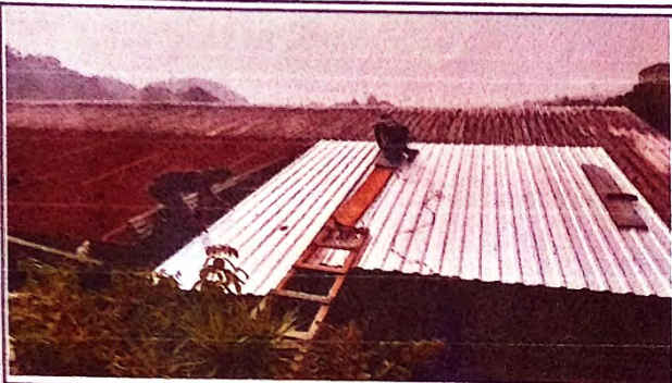
Foto 1: Reparacion de cubierta de lamina a troqueladas
